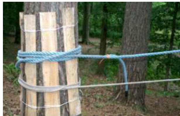
Foto: bevestiging remtouw onder het looptouw
