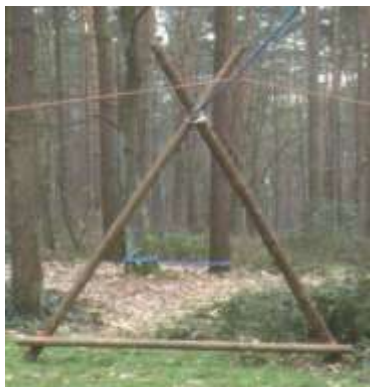
Foto: constructie A-frame
